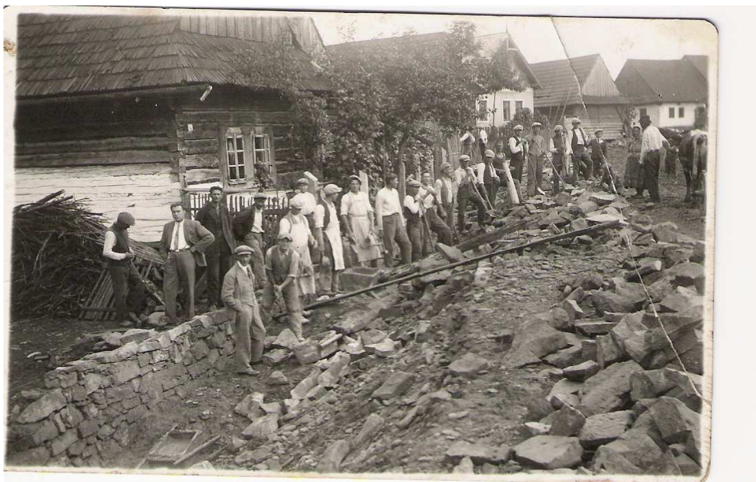
Výstavba cesty v obci
