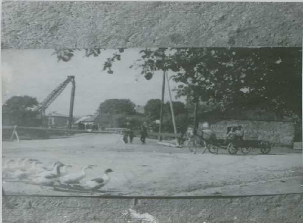
Stavba nového mosta r. 1967 /starý – dřevěný most postavený 1946/
